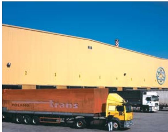
Производственное здание Kimberley Clark, Ключе, Польша
