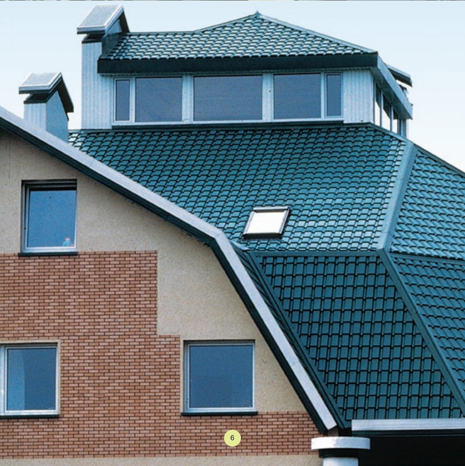
Из большого выбора кровель именно кровля Cascade передает идею традиционных гонтов. Профиль Cascade придает кровле презентабельный и изысканный вид. Для данного типа профиля возможно эффективное применение как на новых, так и на реконструируемых зданиях.
